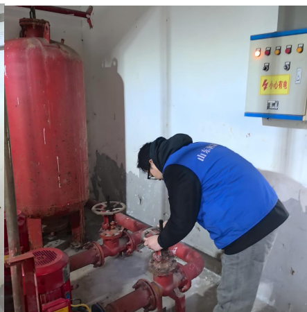
图 108 消防泵房检修
