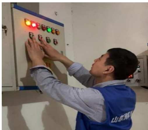
图 162 消防设施维修
