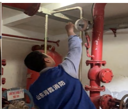
图 163 消防泵房检修
